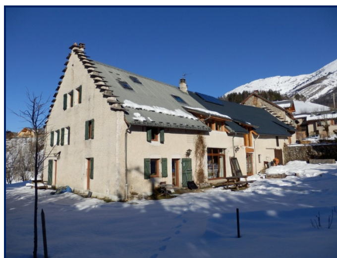
(le gîte de la Montanara à Villard de Lans)
